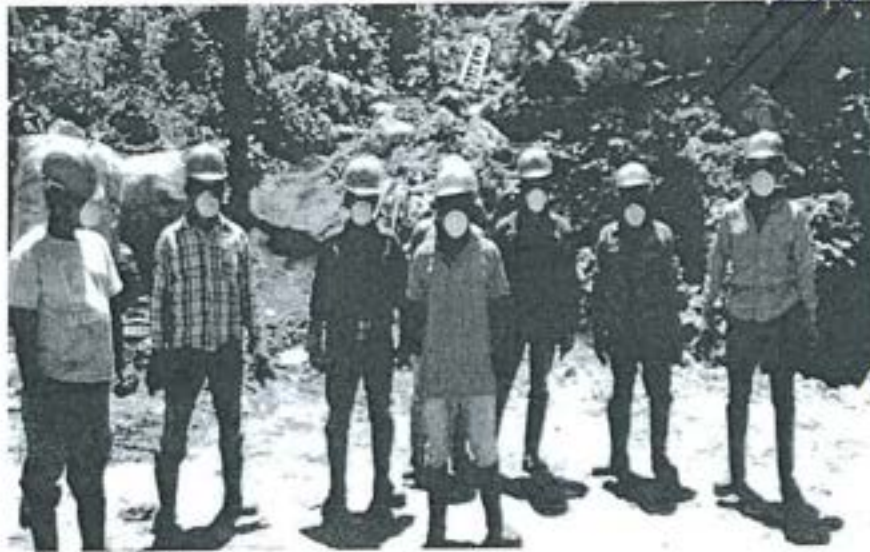
Ilustración 12. Trabajadores con equipo de protección personal.
